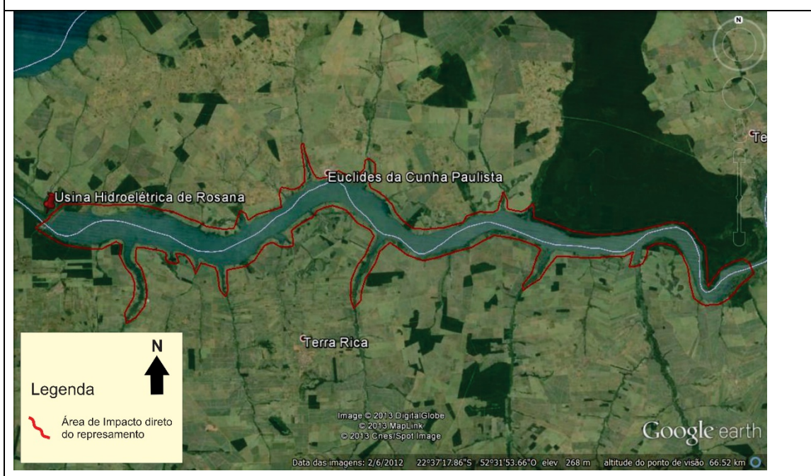
Imagem 2 - Impacto direto do empreendimento – Usina Hidroelétrica Rosana PR
